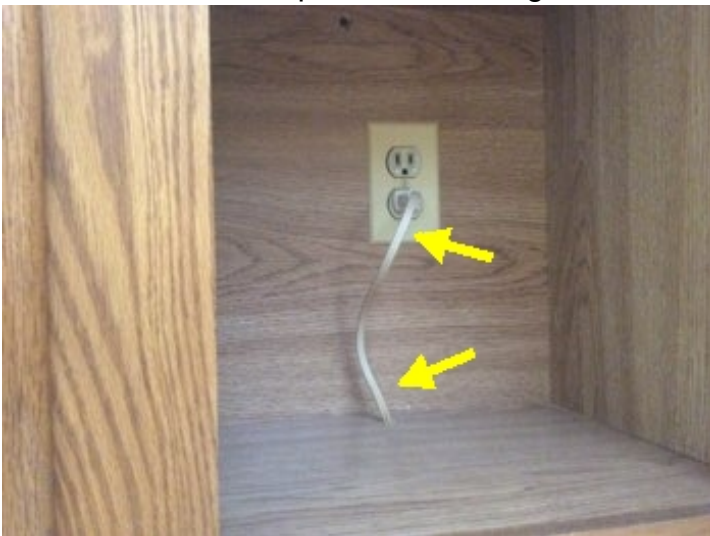
Amateur wiring visible for exhaust fan motor.
