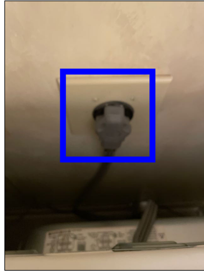
240 Volt Electric Dryer Outlet
